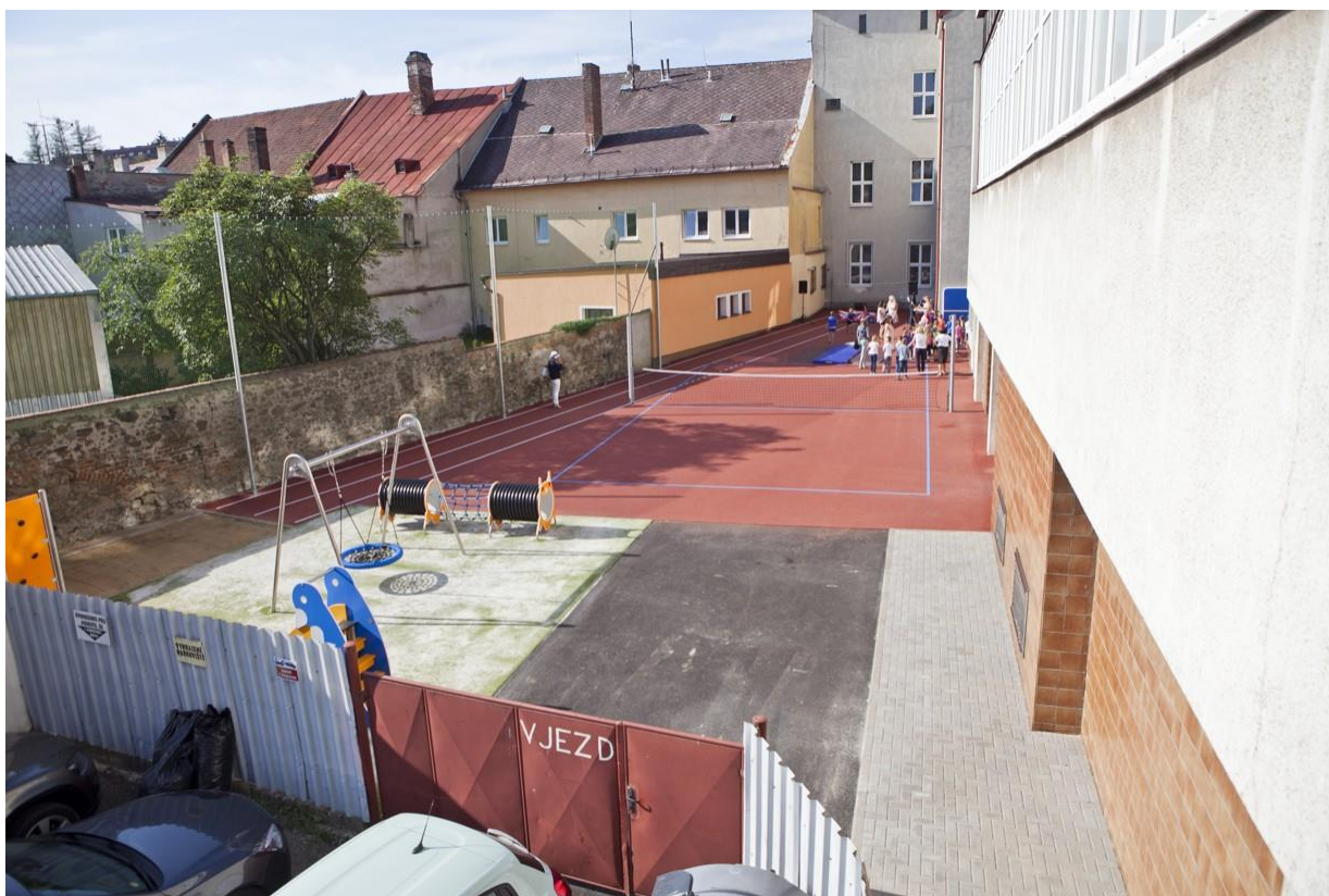
Nové víceúčelové hřiště pro výuku tělesné výchovy na prvním stupni
